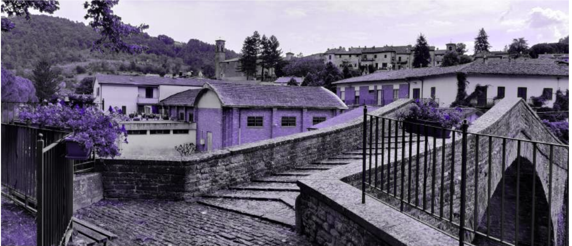
Apecchio, ponte sul fiume Biscubio. Foto ©UNIVPM
