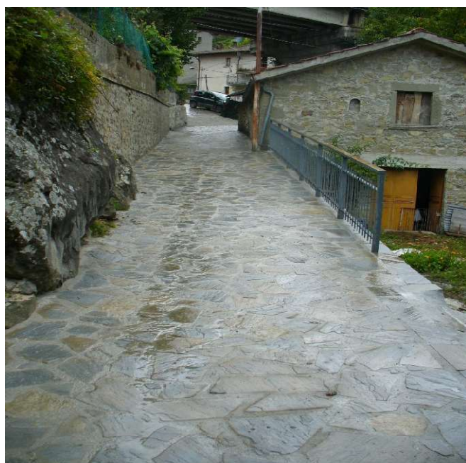
La nuova pavimentazione della strada
